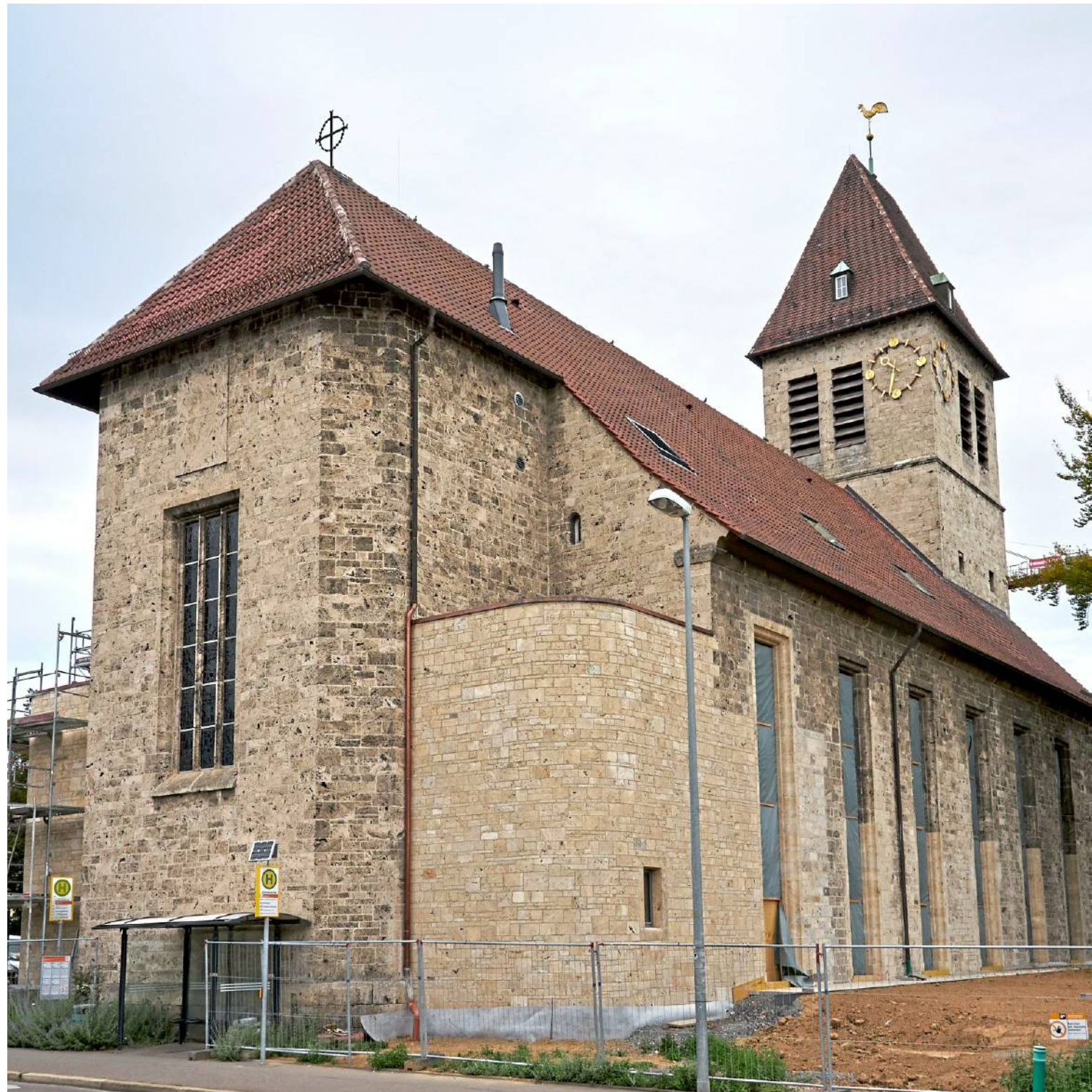
Die Kornwestheimer Johanneskirche sollte schon Ende 2018 fertig sein. Nun dauern die Arbeiten deutlich länger.
