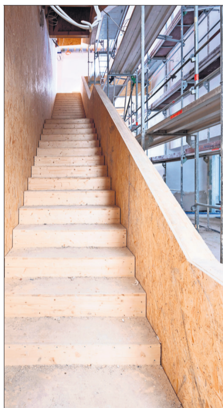
Hier geht's rauf: Einen Aufzug wird es aber auch geben.
