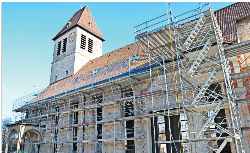
Jetzt noch eine Baustelle, bald das neue Zentrum: die Johanneskirche.
