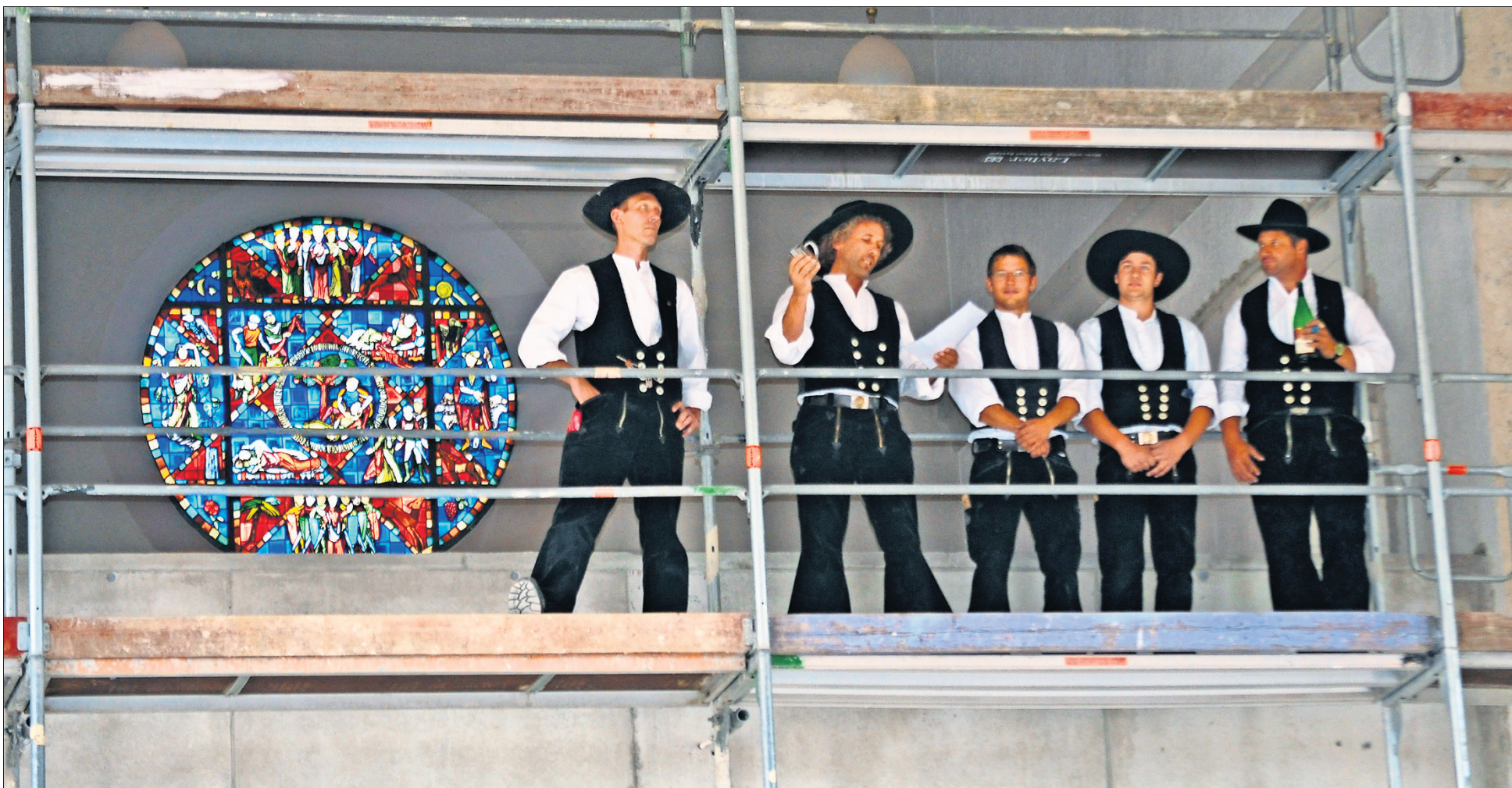
Die Zimmerer sprechen den Richtspruch: Beim Umbau der Johanneskirche ist die Halbzeit erreicht.
