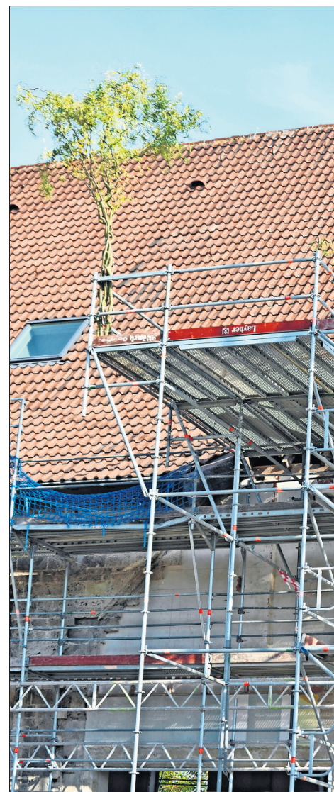
Das Richtbäumle steht am Gerüst an der Johanneskirche.
