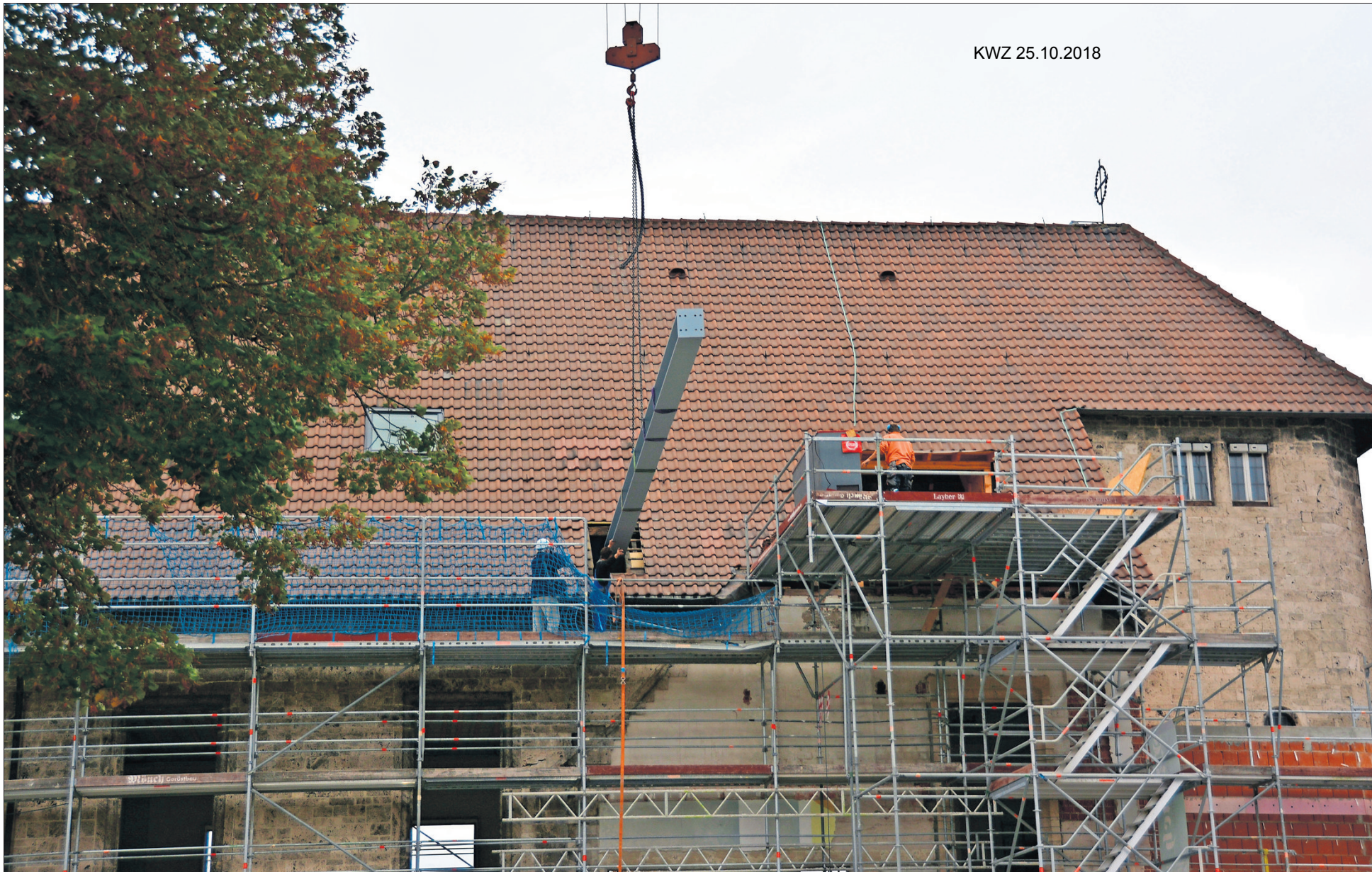
Das Dach geöffnet für zwei Stahlträger: Sie wurden mit Hilfe eines Krans ins kleine Loch eingefädelt.
