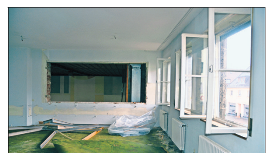
Kaum noch zu erkennen: der Johannesaal
